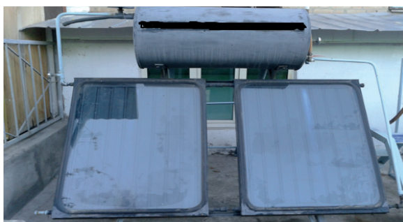
İncir. 2. Güneş ısıtma sistemi.
